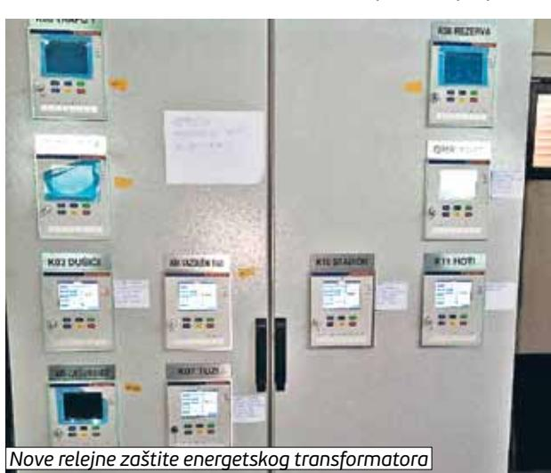
**Nove relejne zaštite energetskog transformatora**
