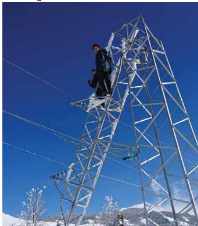
Ni čelično rešetkasti stub nije izdržao
