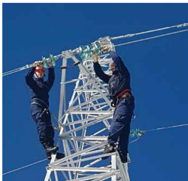
Priprema 35kV dalekovoda za ljetnju sezonu
