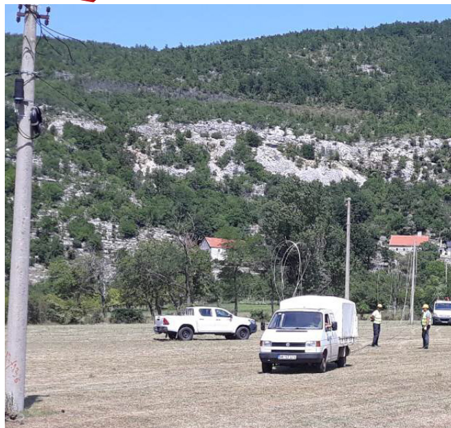
Radovi na DV „Lipova ravan“
