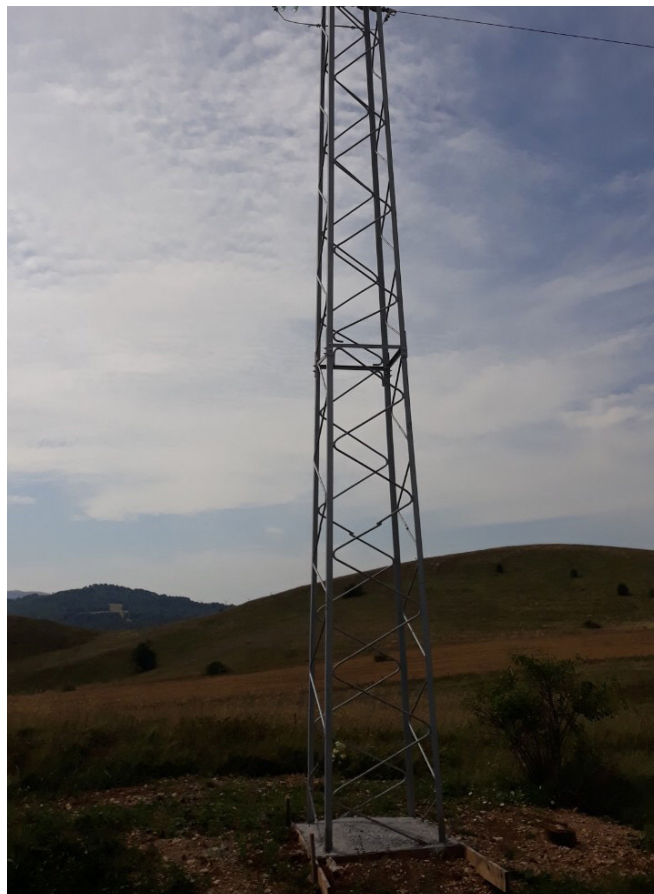
Novi čelično-rešetkasti stub na DV „Timar“
