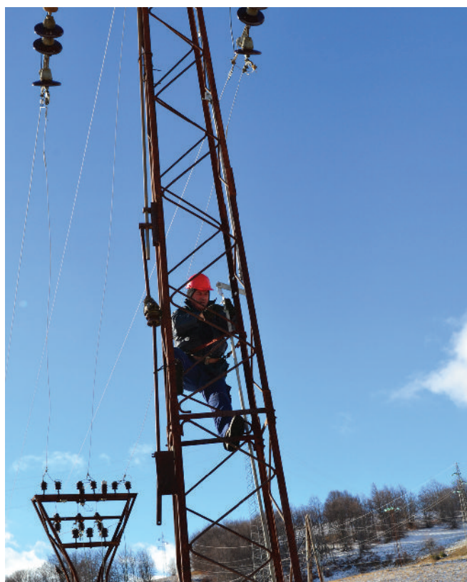
Ugradnja rastavljača na čelično-rešetkastom stubu na DV 10 kV „Timar“. Na stubu Mišo Jakić.
