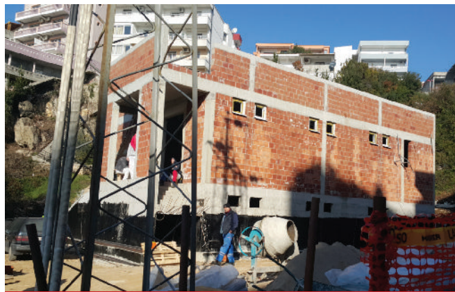
Izgradnja TS 35/10kV „Novi Ulcinj“
