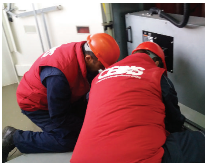
Remont TS "Bistrica"
