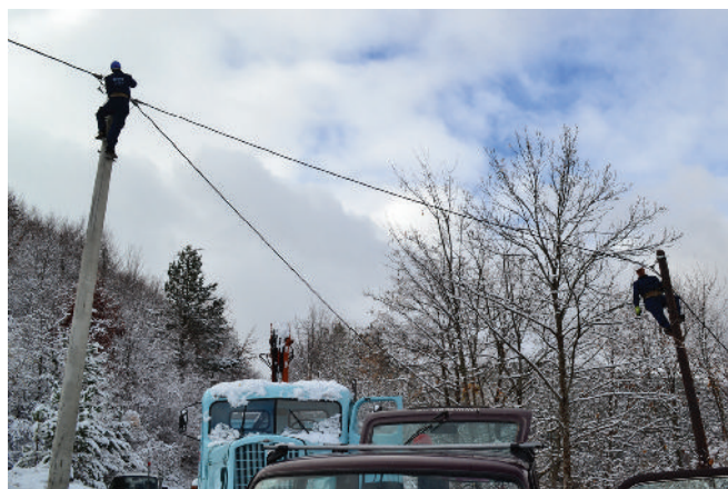
Montaža SKS na novoizgrađenoj NN mreži – izlaz Rasovo na Žabljaku. Na drvenom stubu Dalibor Stjepović, na betonskom Luka Baranin.
