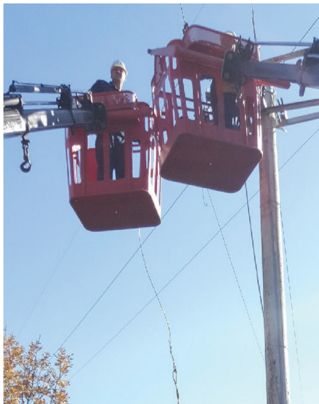
Radovi na DV10kV Kružni II - odcijep Poklonci
