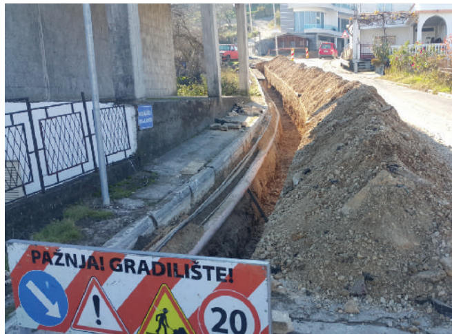
Izgradnja 35 kV kablovskog voda za uklapanje TS „Novi Ulcinj“
