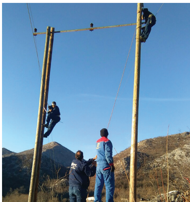
Radovi na 10kV dalekovodu u cetinjskoj opštini
