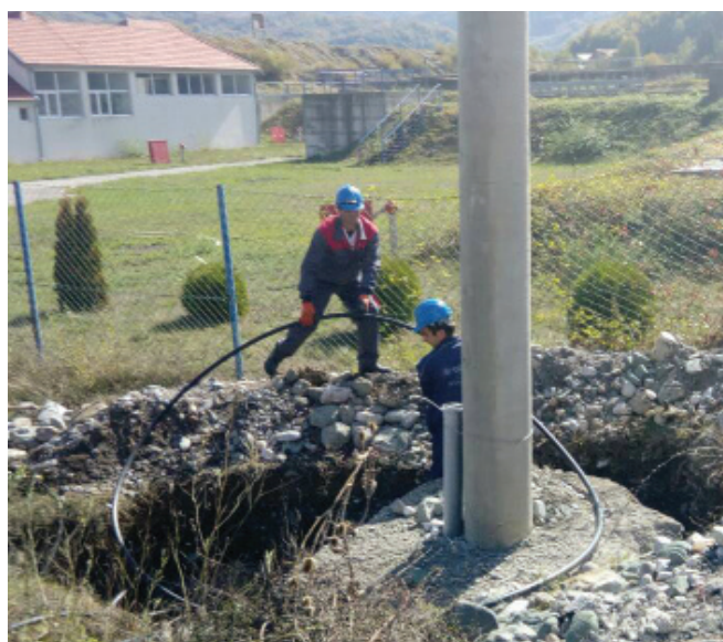
Montaža kablovskog voda
