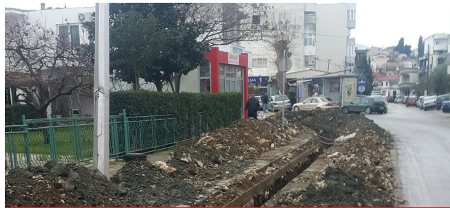
Izgradnja kablovskih vodova za uklapanje TS „Ulcinj“
