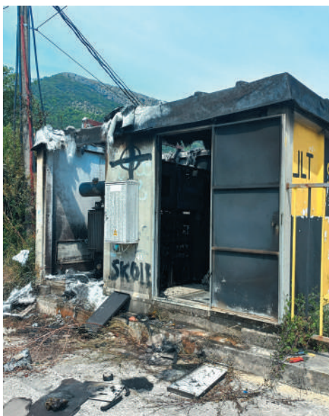
OBJEKAT I OPREMA STRADALI ZBOG PREOPTEREĆENJA
