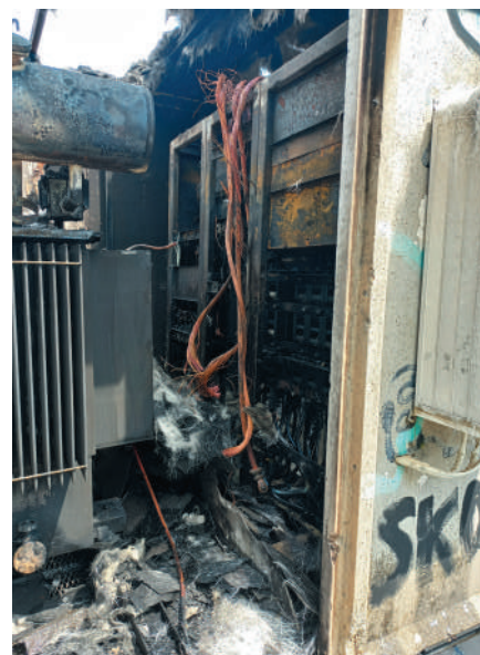
OBJEKAT I OPREMA STRADALI ZBOG PREOPTEREĆENJA
