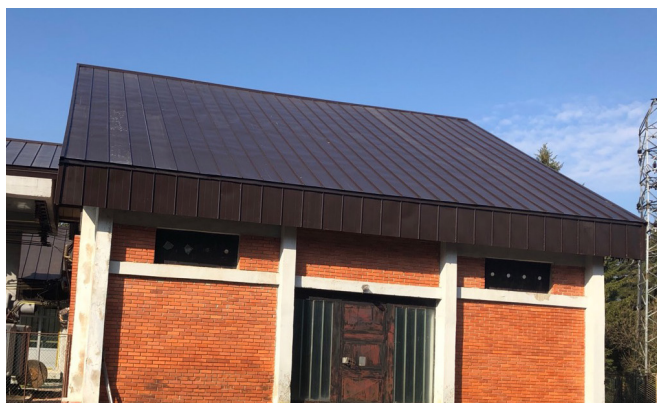
Rekonstruisan krov na TS “Žabljak”
