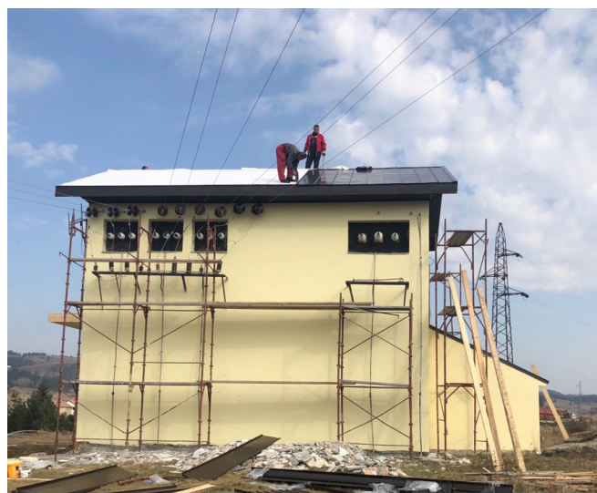
Rekonstrukcija krova na TS "Kosanica"
