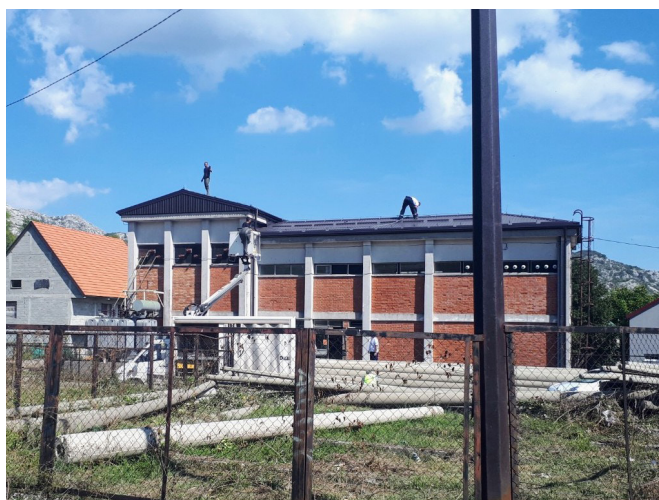
Ugradnja gromobranske instalacije na TS "Novi Obod"
