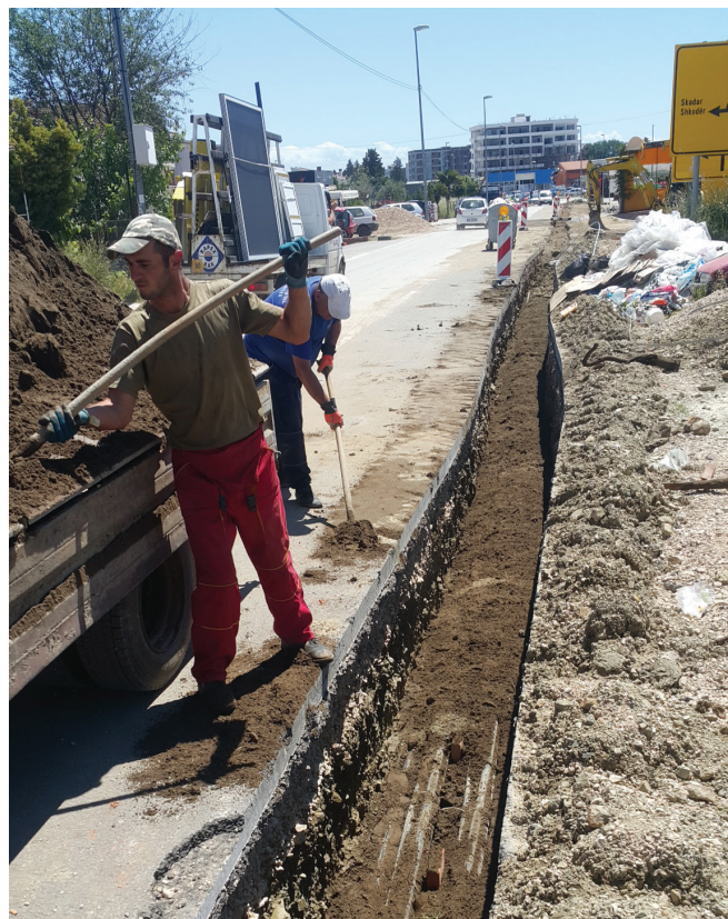
Ugradnja kablovskog voda
