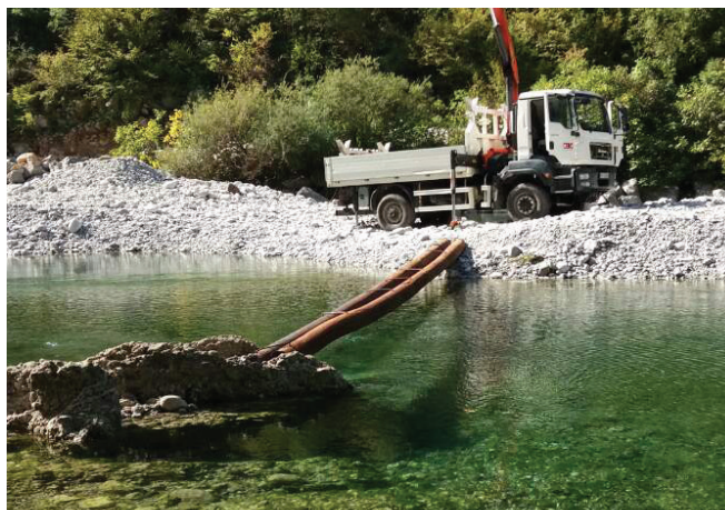
Improvizovani most za prenošenje opreme
