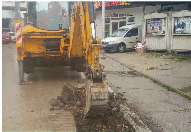
Ugradnja kablovskog voda
