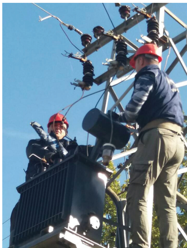
Zamjena trafoa u STS "Kaševari"
