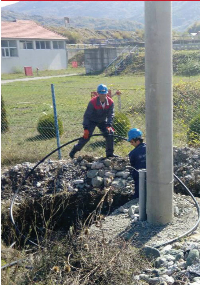
Montaža kablovskog voda na AB stubu na DV 10 kV "Tutice"
