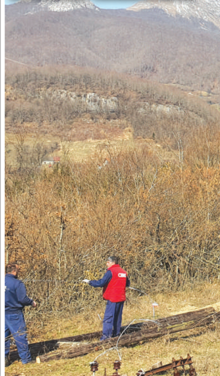
Rad na čelično-rešetkastom stubu
