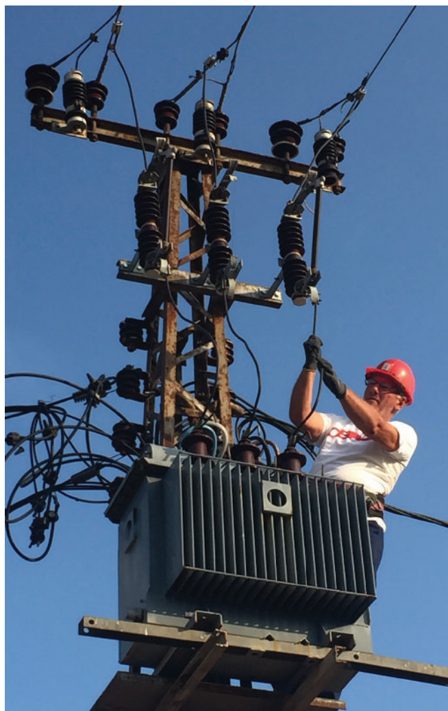
Isključenje tehnički neispravnog priključka na Adi
