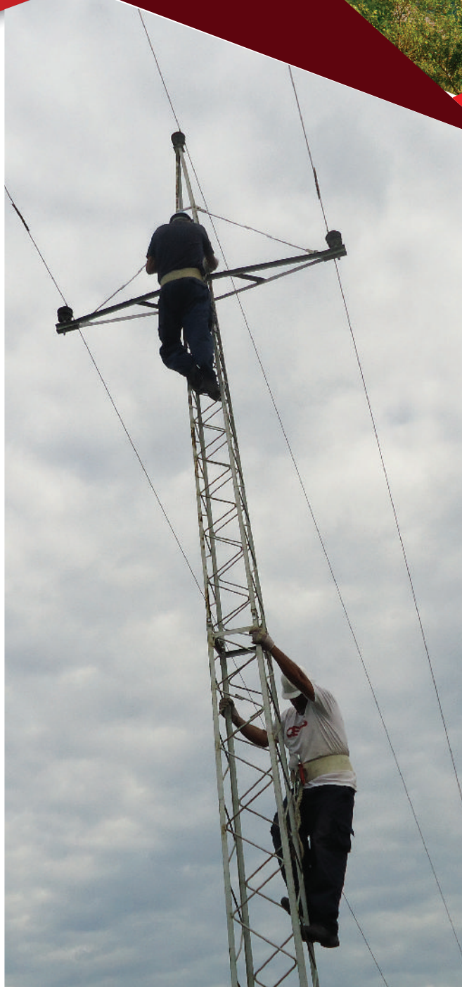
Intervencija na dalekovodnom stubu
