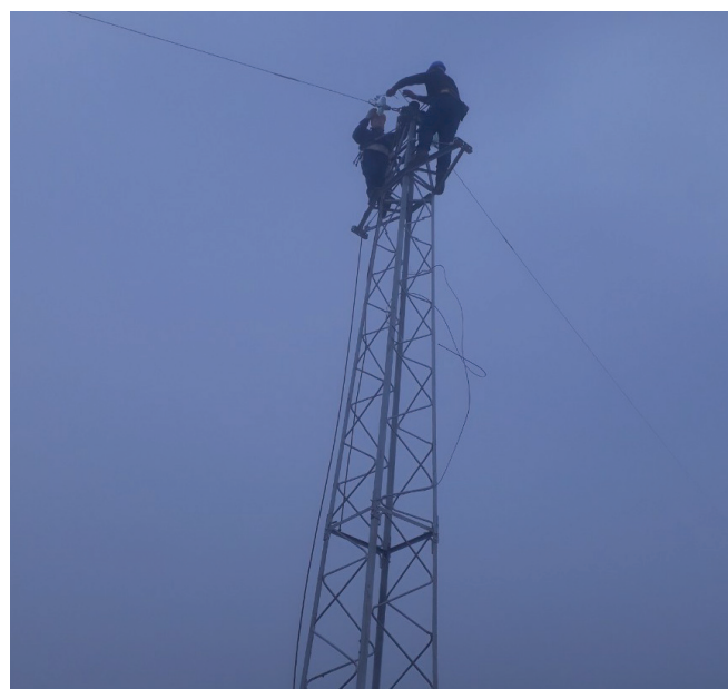
Montaža čelično rešetkastog stuba na DV „Tomaševo“
