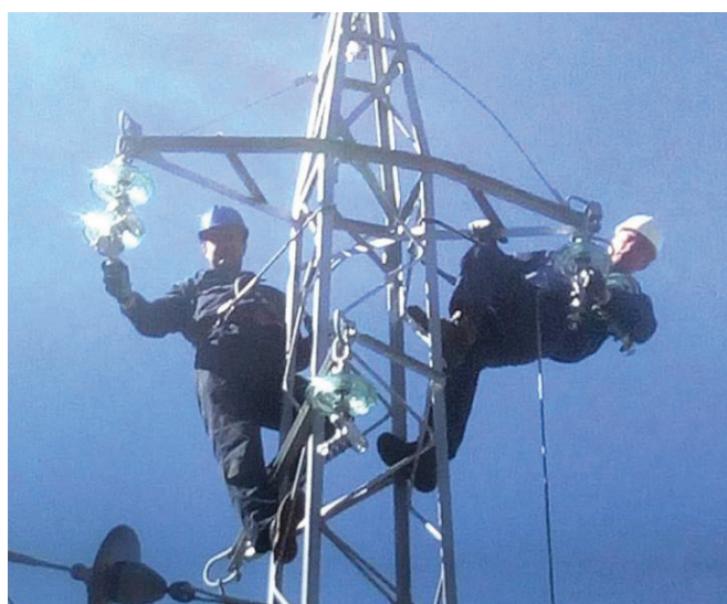
Montaža čelično rešetkastog stuba na DV „Skrbuša“ u Kolašinu
