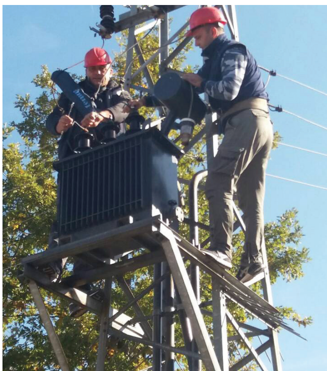
Zamjena transformatora na STS u Bijelom Polju
