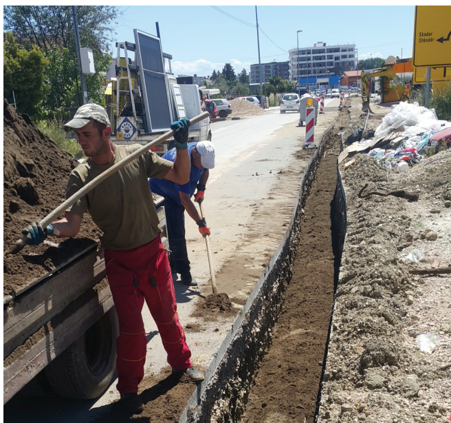
Ugradnja kablovskog voda
