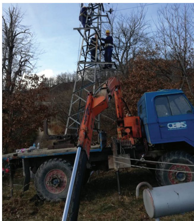
Rekonstrukcija STS "Pobrisijevići" u Mojkovcu
