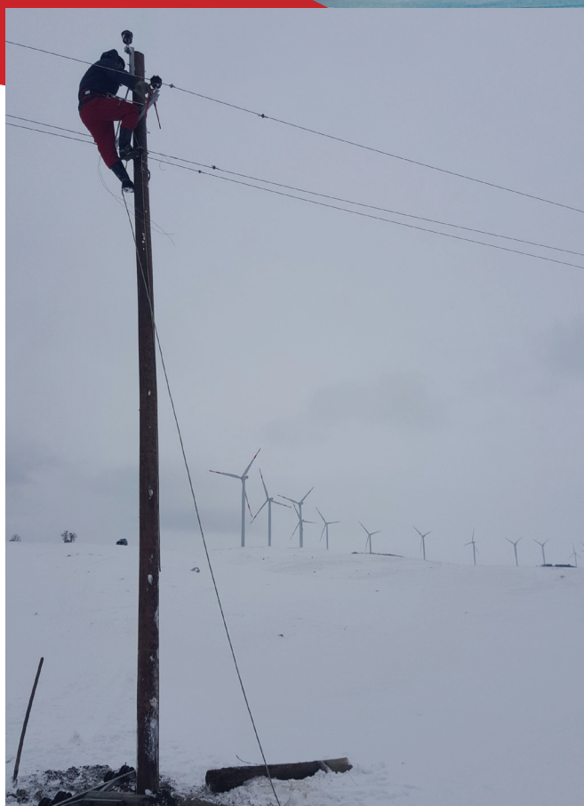
Ugradnja novog stuba na DV "Lukovo"
