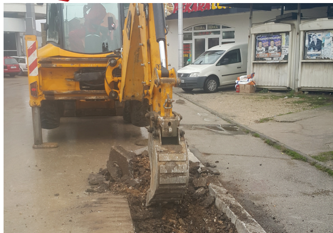
Ugradnja kablovskog voda
