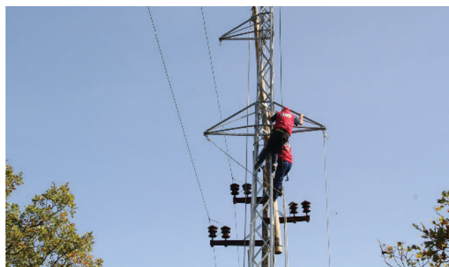
Montaža čelično-rešetkastog stuba
